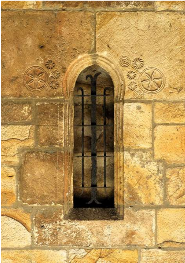
Ventana gótica del muro sur. © GSM.
