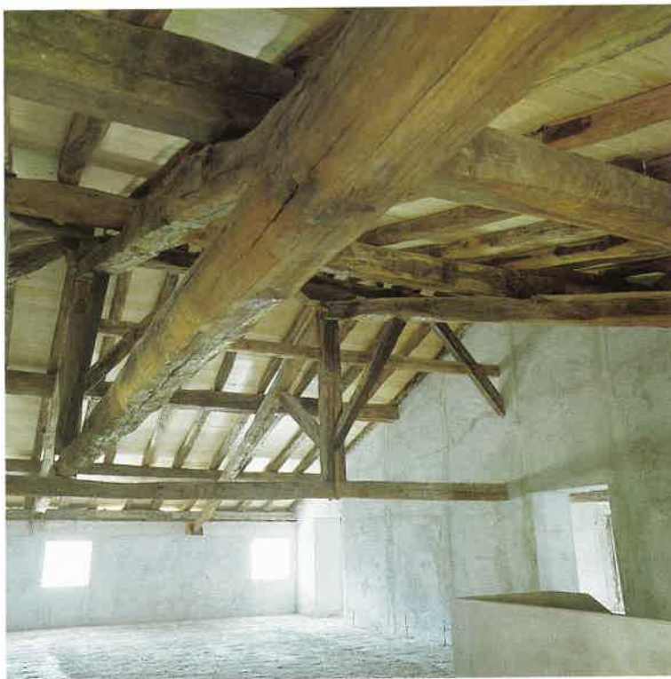
Detalle del entramado de las vigas de la cubierta. / Estalkiko habeen bilbaduraren xehetasuna.
