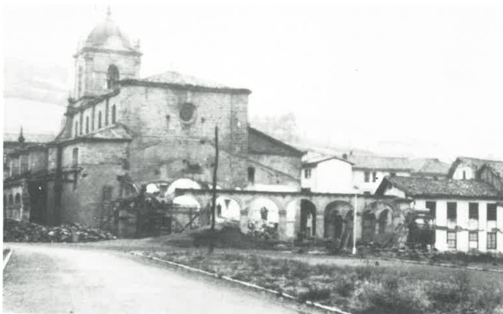
Parte trasera de la iglesia parroquial con arcos y sacristía derribados para su restauración. Año 1961.
