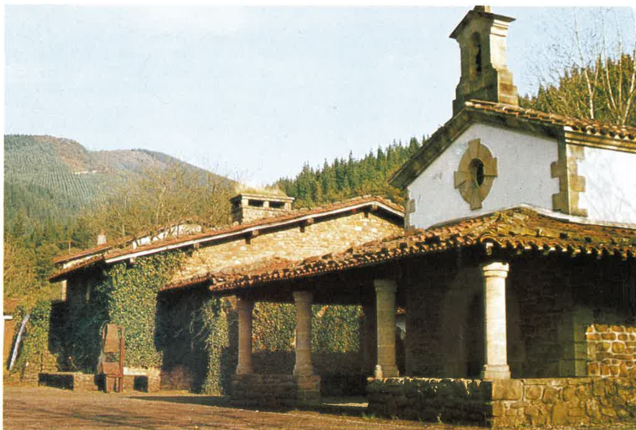
Conjunto arquitectónico formado por la ermita y ferrería de Mirandaola.
