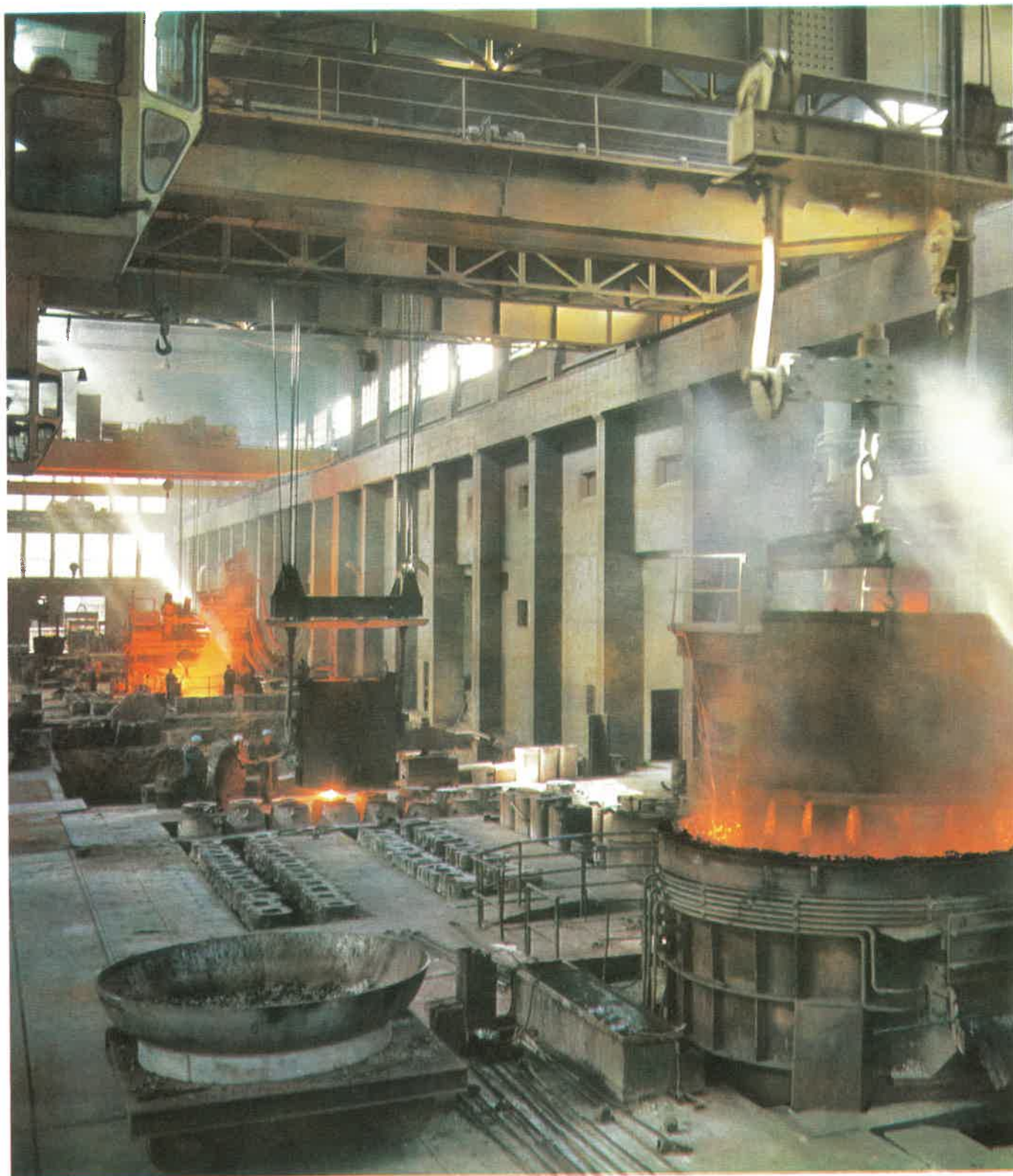
Acería. Hornos eléctricos de arco.
