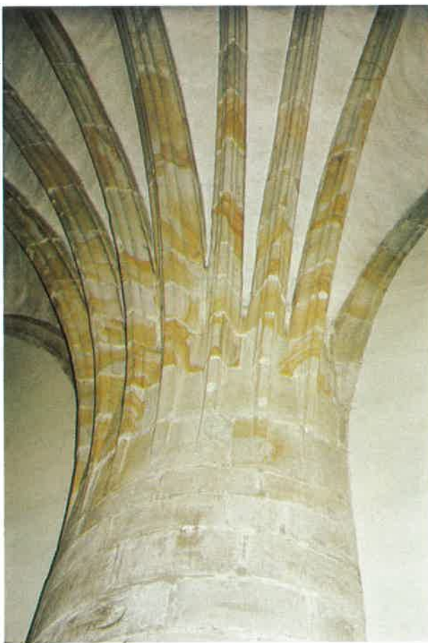
Las seis columnas de la iglesia carecen de capitel. De ellas surgen varios nervios que se abren a modo de palmera para cruzarse en las bóvedas.
