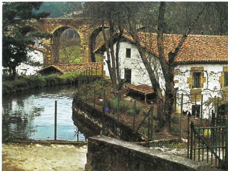
Canal y casería de Igeralde
