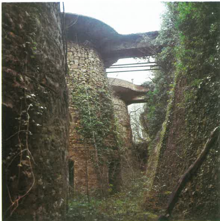
Restos de hornos de calcinación de mineral en Aizpea. Explotación industrial de este siglo
