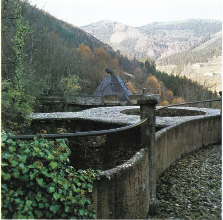
Horno para calcinación de mineral de hierro. Trabajaba en Aizpea a principios de siglo
