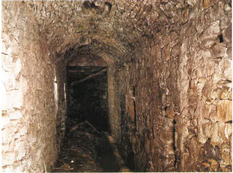
Restos de la ferrería localizados en la actual casa de Olaberria
