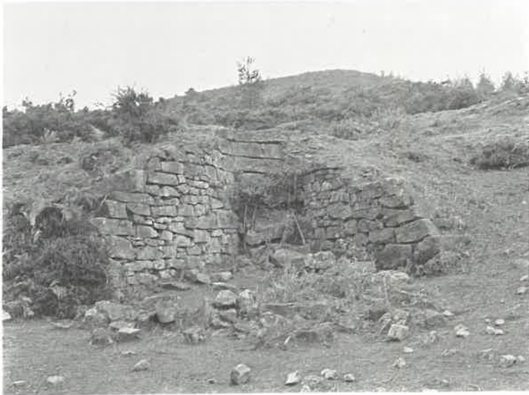
“Karobi” o calero en Otaño, próximo a las minas y a las antiguas “haizeolak”. El proceso de obtención de la cal era similar al de la calcinación de la vena
