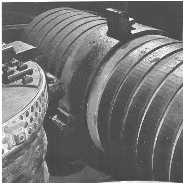
Accionamiento de fuelles. Los dientes del eje mueven los "esgamelak" de los fuelles
