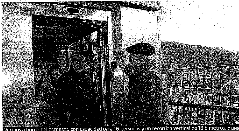
Vecinos a bordo del ascensor, con capacidad para 16 personas y un recorrido vertical de 18,8 metros. de CRISTINA LIMIA
