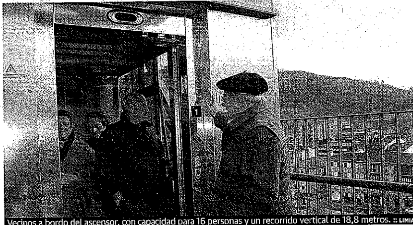
Vecinos a bordo del ascensor, con capacidad para 16 personas y un recorrido vertical de 18,8 metros. :: LIMIA
